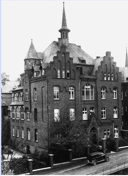
Geschichtsträchtige Mauern: 1850 auf dem Roßmarkt gegründet, zog das St. Vincenz-Hospital 1905 in das hier abgebildete Gebäude am Hüttig.
