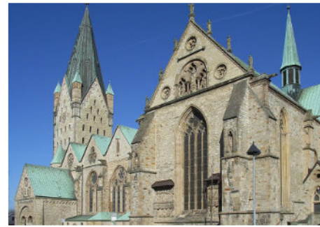
Südseite des Paderborner Doms
